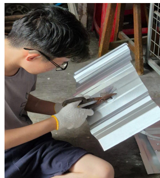
Pemotongan Atap Seng
