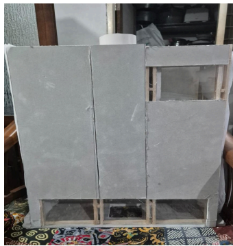
Penempelan Gypsum pada Rangka
